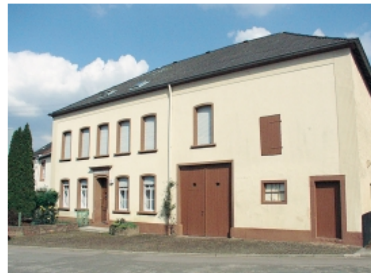
Gut renoviertes Trierer Einhaus im Serriger Weg (Foto: M. Lutz)
